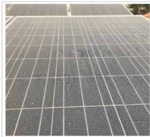
Imagen 1 Módulos fotovoltaicos antes de su limpieza
