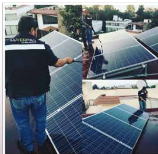
Imagen 2 Durante el proceso de limpieza de los módulos fotovoltaicos
