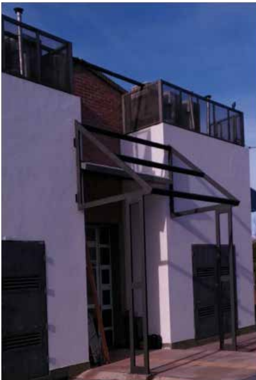
Figura 2: Instalación de estructura.
